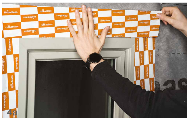
Sigillare i giunti della finestra all'interno e all'esterno.
