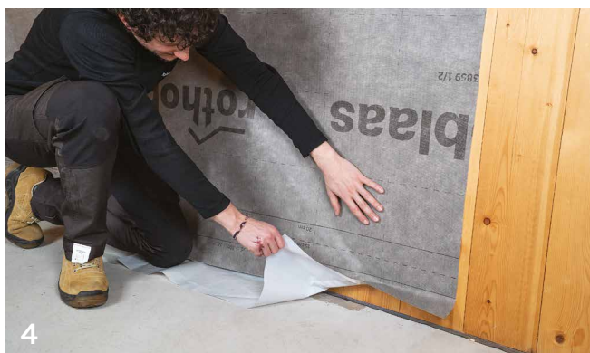
4 Rimuovere il secondo strato di separazione e farlo aderire al supporto dal centro del foglio.
