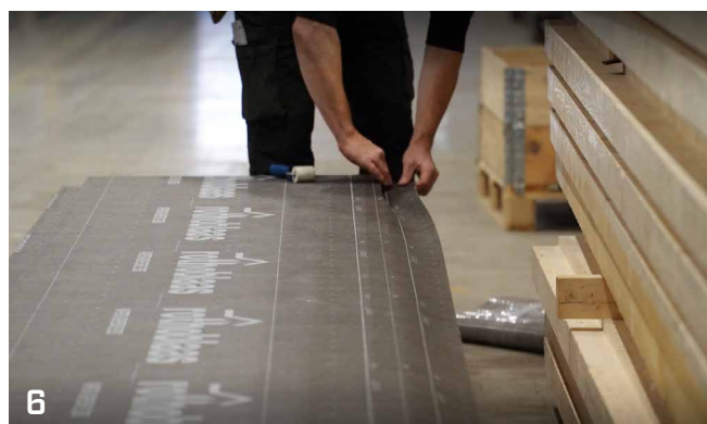
6 La membrane adhésive doit envelopper tout le panneau.
