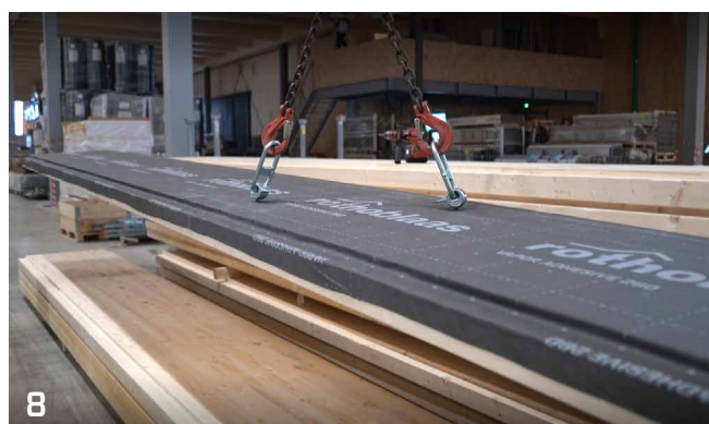
8 Les panneaux ainsi préparés sont faciles à transporter sur les chantiers.
