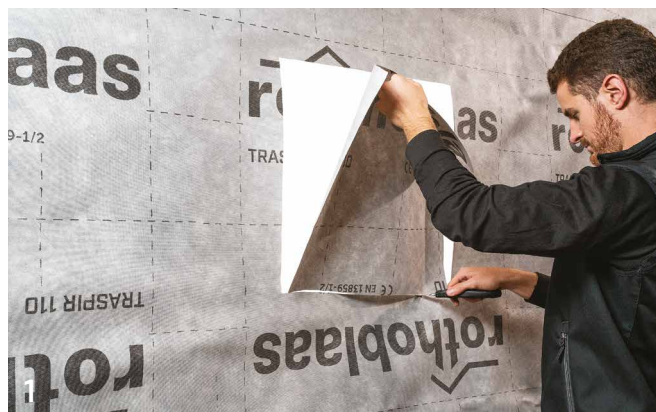
Découper les ouvertures des fenêtres.
