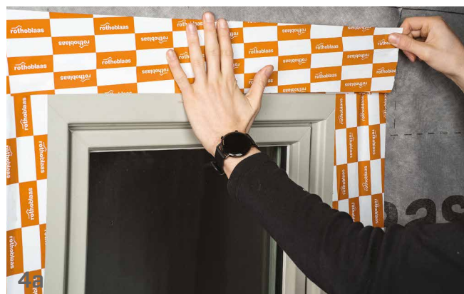
Sceller les joints de la fenêtre à l'intérieur et à l'extérieur.
