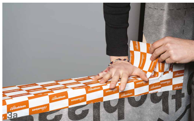
Sceller la fenêtre avec le ruban adhésif Rothoblaas.
