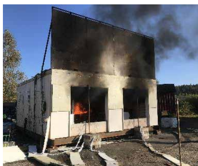
Foto des Abschnitts nach dem Entzünden
