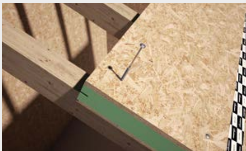
Fastsättning av SIP-paneler med skruvar TBS med diameter 8 mm.
