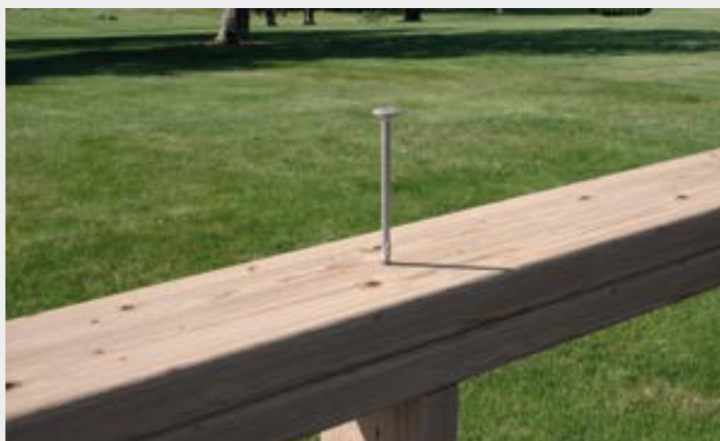
Fixarea grinzilor de lemn la exterior.
