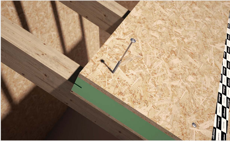
8mm 직경의 TBS 스크류로 SIP 패널을 고정합니다.
