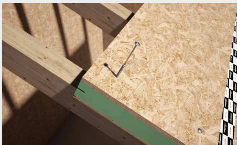
^ SIP-levyjen kiinnitys 8 mm:n TBS-ruuveilla.
