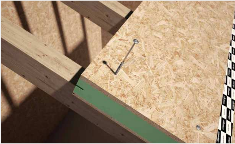
8mm 직경의 TBS 스크류로 SIP 패널을 고정합니다.
