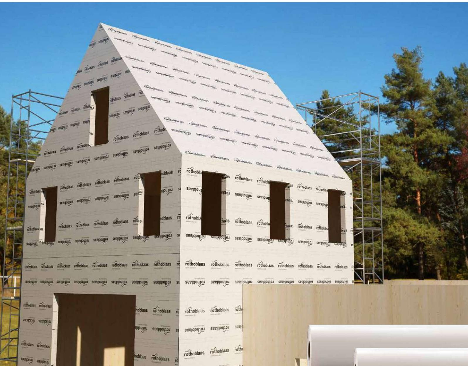
Notre gamme de membranes autocollantes est en constante expansion. Nos membranes BARRIER, BARRIER ALU, VAPOR IN, CLIMA CONTROL, VAPOR, TRASPIR et BYTUM peuvent acquérir une valeur ajoutée en version autocollante : grâce à la colle, elles sont rapides à poser et peuvent être utilisées à la fois comme protection pendant la construction et comme couche fonctionnelle dans la stratigraphie.
