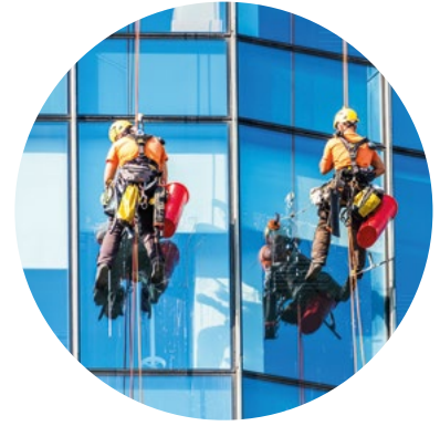
LIMPIEZA DE VIDRIOS
